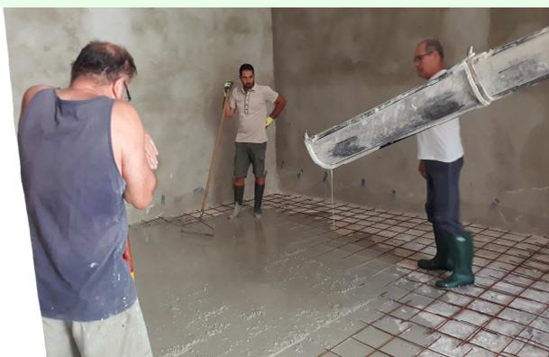
Le 10 août dernier une équipe du Comité des Fêtes dont un élu ont procédé au décaissement du sol de ce local pour retirer l'enrobé à froid et préparer la surface pour recevoir une dalle béton. Le 19 août, la dalle béton est coulée. Le Maire salue la mobilisation des moyens humains et techniques par le Comité.
