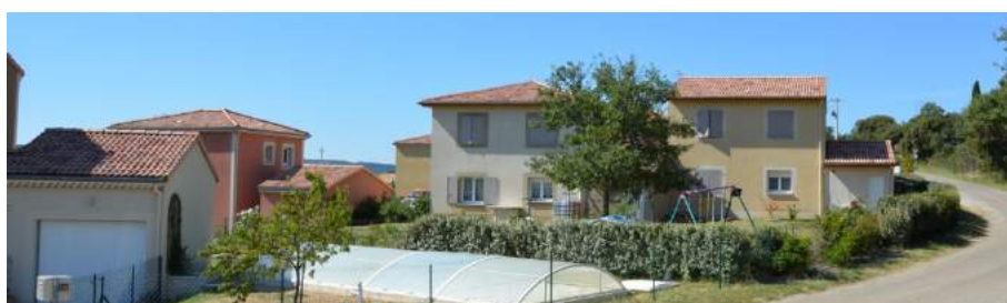
Habitat groupé très récent (opération récente).
